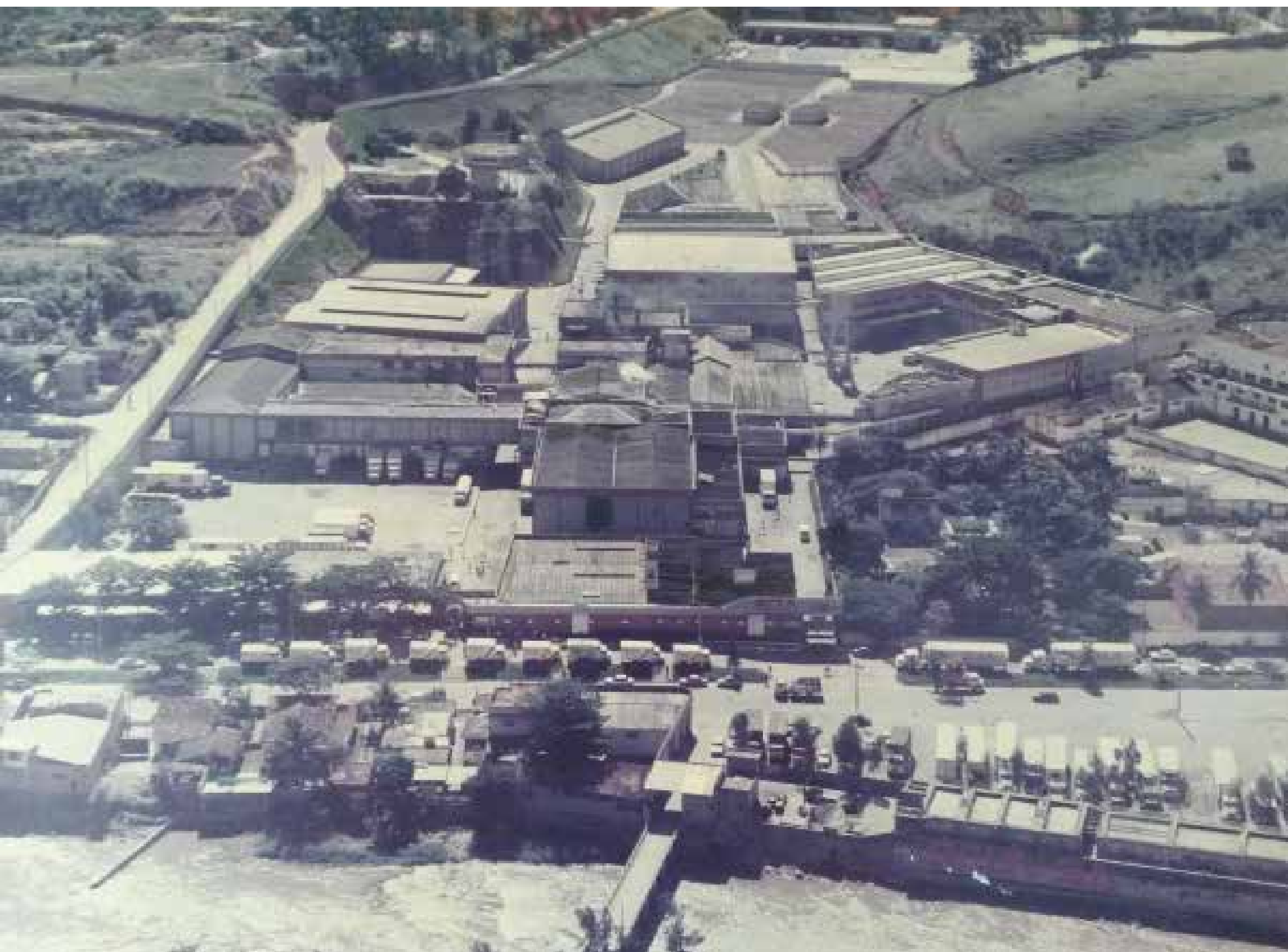
Vista aérea de um dos Frigoríficos Sola, em Três Rios, RJ. An aerial view of one of the Sola meat plants, at Três Rios, RJ.
